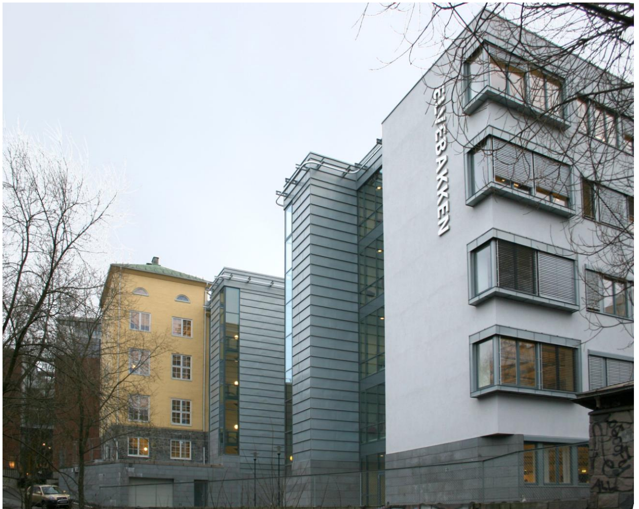
Fasader mot Akerselva.
